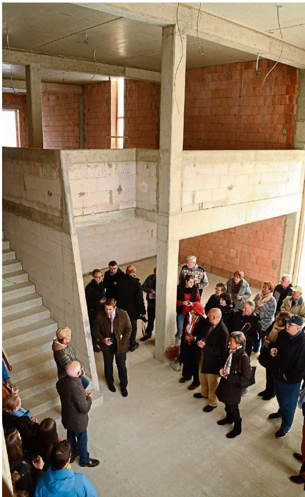
Blick in das Innere der Taunussteiner Kunsthalle, die in Niederlibbach gebaut wird. Foto: RMB/W. Kühner
